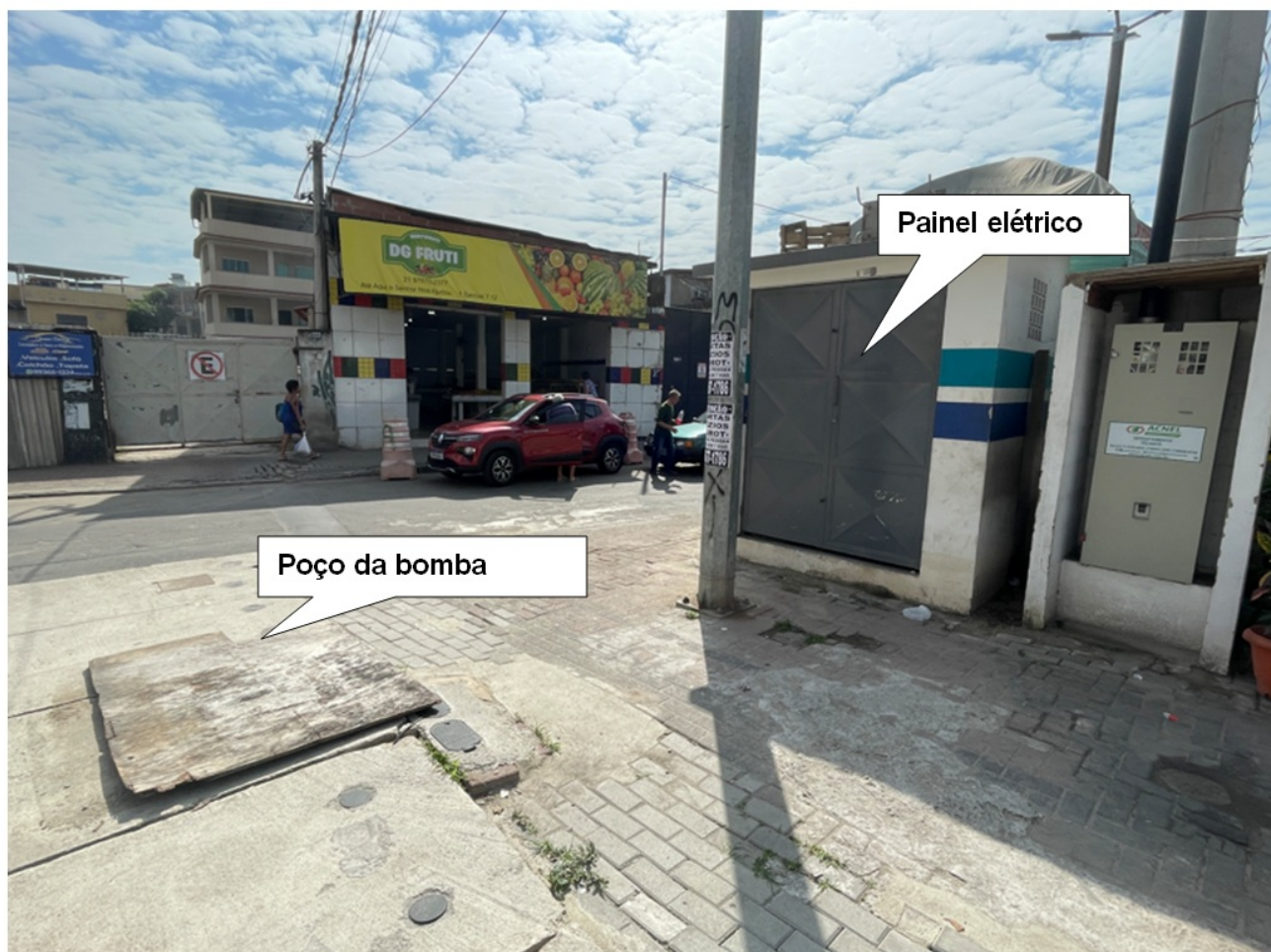
Foto 1 – Estação Elevatória Água Tratada 25 de Agosto localizada em calçada de via pública
